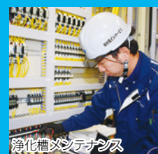
浄化槽メンテナンス
